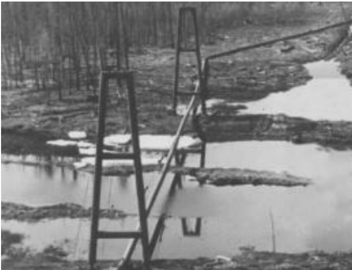
Строительство газопровода Таас-Тумус-Якутск-Покровск. 10 июля 1967 г. Автор съемки – В. Тетерин
