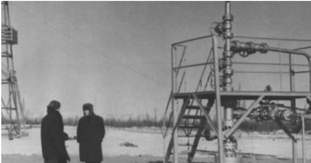
Скважина №1 в районе Таас-Тумус, откуда начался газопровод, по которому природный газ поступает в г.Якутск. Кобяйский район ЯАССР, 1967 г.
