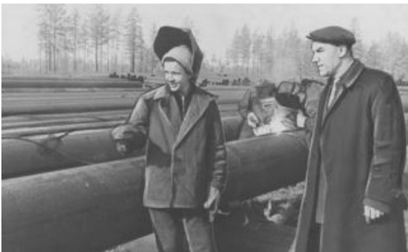
Сварщик В. Семенов (слева) и начальник строительства первого магистрального газопровода на вечной мерзлоте Таас-Тумус-Якутск Д.С. Юрков.
